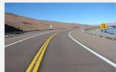
Interrupción de caminos
